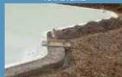
ASSISE BÉTON DES MARGELLES
