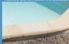
POSE DES MARGELLES
