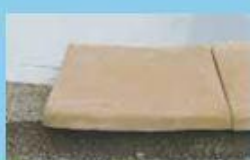
POSE DES MARGELLES
