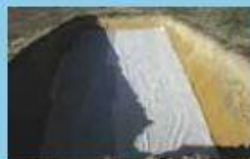
POSE DU GEOTEXTILE
